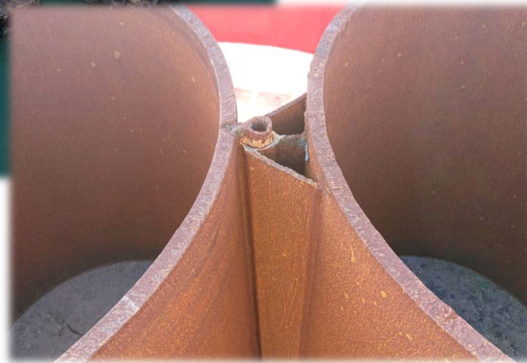
Clutch pipe piles
